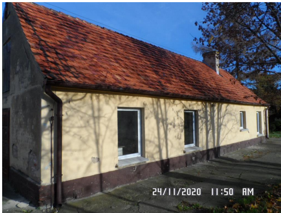
1. Widok ogólny budynku
